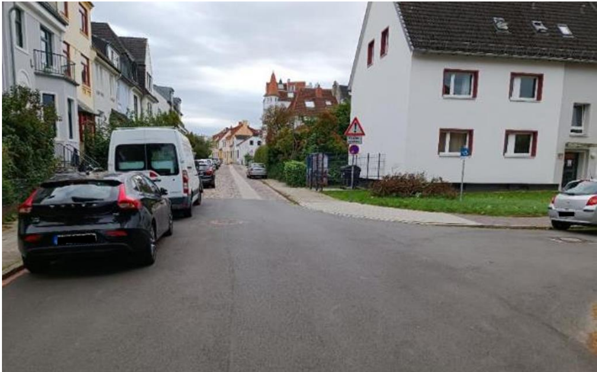
Abbildung 91: Guter Kompromissansatz mit Ausbau- und Anschlusspotenzial - asphaltierte Straße mündet in traditionelles Kopfsteinpflaster mit mittigem Radfahrstreifen (Schaumburger Str., rechts Anna-Lühning-Str.). Im Hintergrund durch Kfz vollständig blockierter Gehweg - ein Indiz für die Notwendigkeit häufigerer Kontrollen (Foto: eco).
